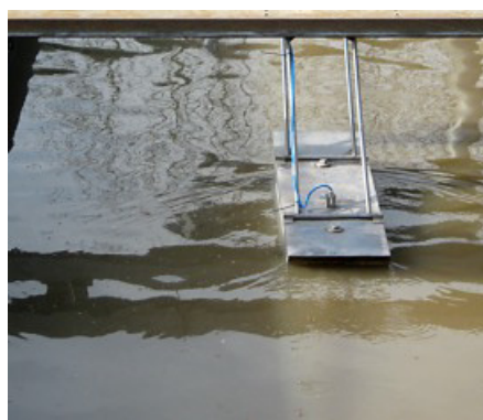
Misuratori di portata con sensori di velocità installati su piattaforma galleggianti.
