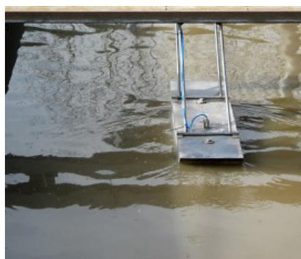
Misuratori di portata con sensori di velocità installati su una piattaforma galleggiante.
