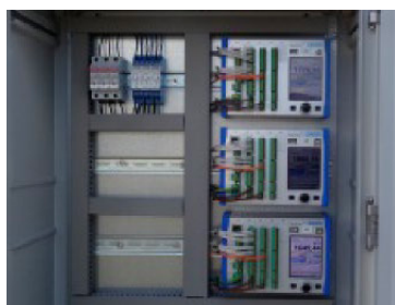
NivuFlow è disponibile come unità per l'installazione in quadri di comando o con una robusta custodia da campo
