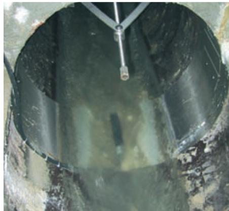
Trasduttore di velocità SPEEDY a immersione installato sul fondo della condotta
